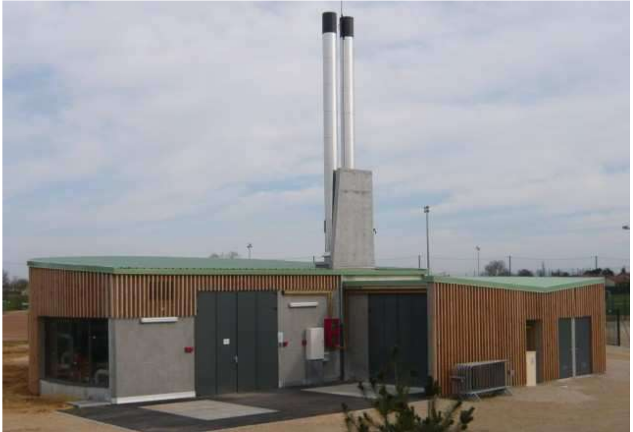
Exemple de chaufferie bois à Saint Denis-lès-Bourg (01) de puissance 800 kW, de surface 200m 2 et consommant 600 tonnes de bois par an.
